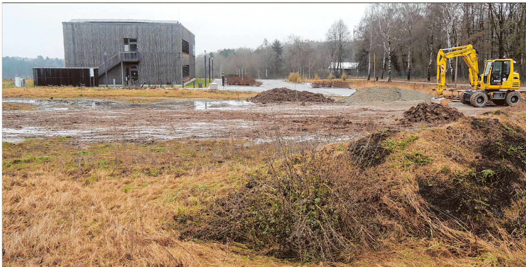
Erste Vorbereitungen auf der Baustelle am Hochschul-Campus in Feuchtwangen sind bereits angelaufen: Das neue Hörsaal-Gebäude soll auf der Fläche im Vordergrund entstehen und über einen gläsernen Steg mit dem bereits bestehenden Labor verbunden werden. Foto: Peter Zumach
